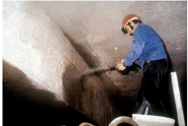
(Figura 2e). Afortunadamente no se produjeron fallos de tipo estructural y por ello no fue necesario demoler posteriormente plantas completas – un trabajo peligroso a una altura de más de 100 m por encima del terreno. Fue posible reparar in situ la mayoría de los elementos reutilizando y reforzando las armaduras y protegiéndolas con hormigón proyectado (Figura 2f).
