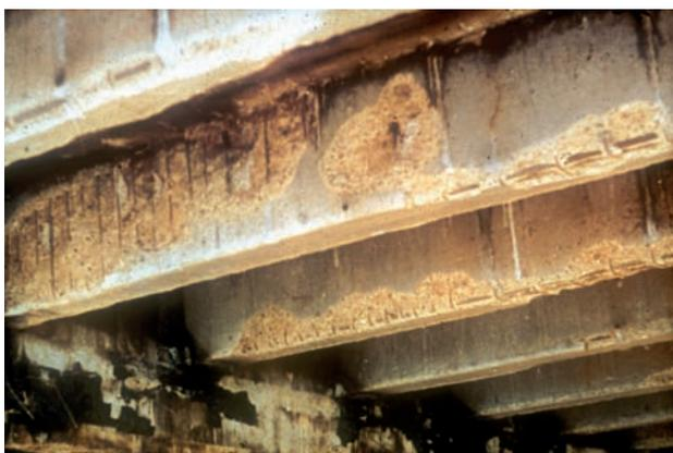
Figura 2f.- Reparación de elementos con gunita (hormigón proyectado). (Por cortesía de DBV, Alemania).
