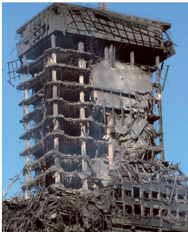
Figura 4b.- La fachada por encima de la planta técnica del piso 16 quedó completamente destruida. (Cortesía de IECA, España).
