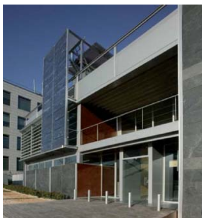
Figura 6a y b.- Edificio Ecobox, Fundación Metr poli para un futur sostenible, edificio de oficinas de hormig n energ ticamente eficiente situado en Madrid (Espa a). (cortes a de los arquitectos Vicente Olmedilla y  ngel de Diego, Espa a)
