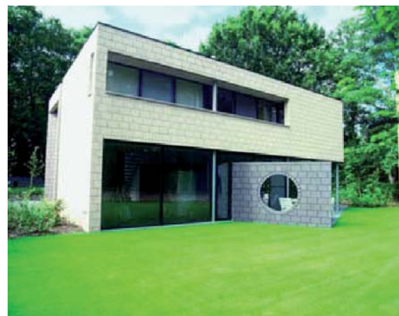
Figura 1d.- Edificio de fábrica de bloques de hormigón en Bonheiden, Bélgica. (Cortesía del arquitecto – Gie Wollaert, Fotógrafo – FEBE, Asociación Belga del Prefabricado, Bélgica).
