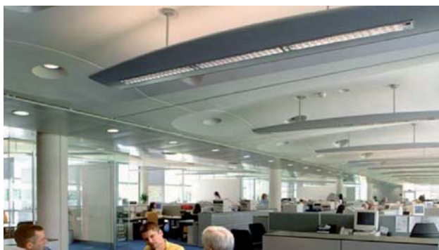
Figura 1b.- Ambiente de oficina confortable proporcionado por el uso de todas las ventajas que aporta la masa térmica del hormigón: Oficinas Centrales de Toyota, Reino Unido (Cortesía de The Concrete Society, Reino Unido).
