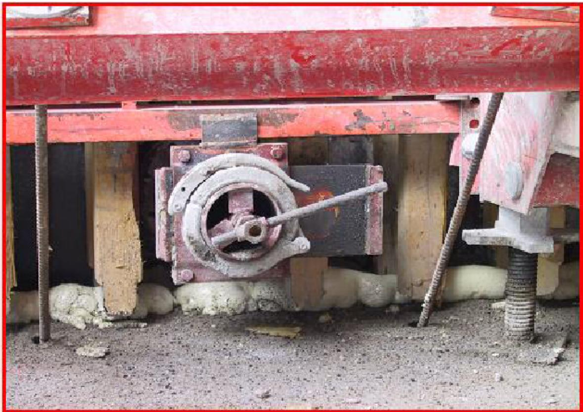
**Figura 10.1:** Al finalizar el bombeo desde abajo, el hormigón sobrante puede ser retirado por la parte interior del encofrado mediante una válvula especial o la superficie se podrá acabar después de retirar el encofrado.
