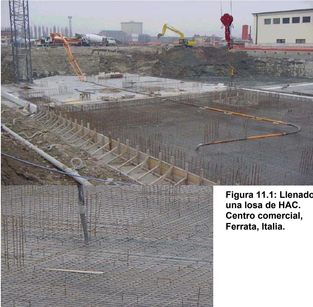
**Figura 11.1: Llenado de una losa de HAC. Centro comercial, Ferrata, Italia.**
