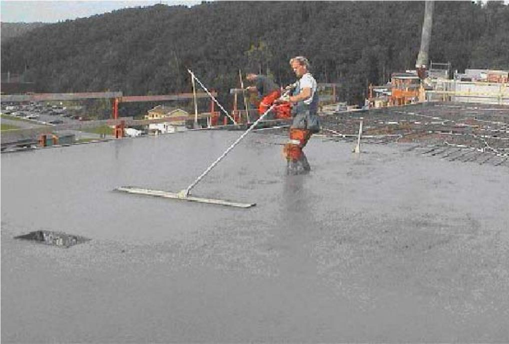
**Figura 11.1 Nivelado del HAC con una regla flotante**
