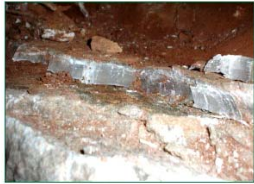
YESO HIDRATADO COLMATANDO FISURA
